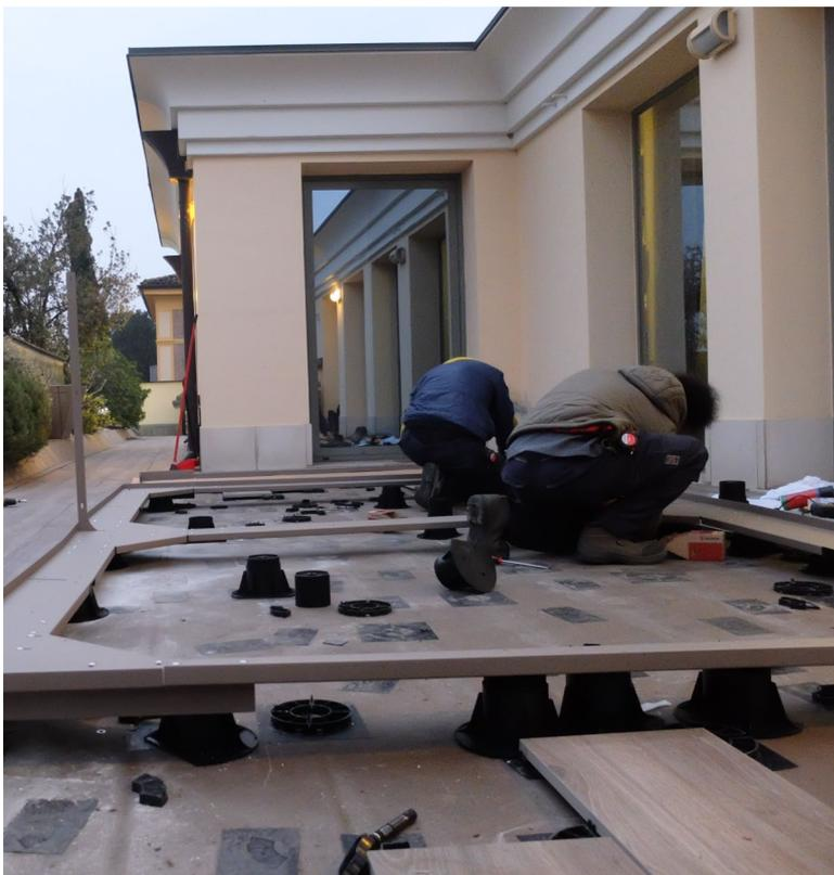
La struttura in acciaio a cui vengono fissate le colonne delle pergole deve collaborare con il proprio peso e quello del gres a rendere stabile la pergola anche in caso di forte vento.
