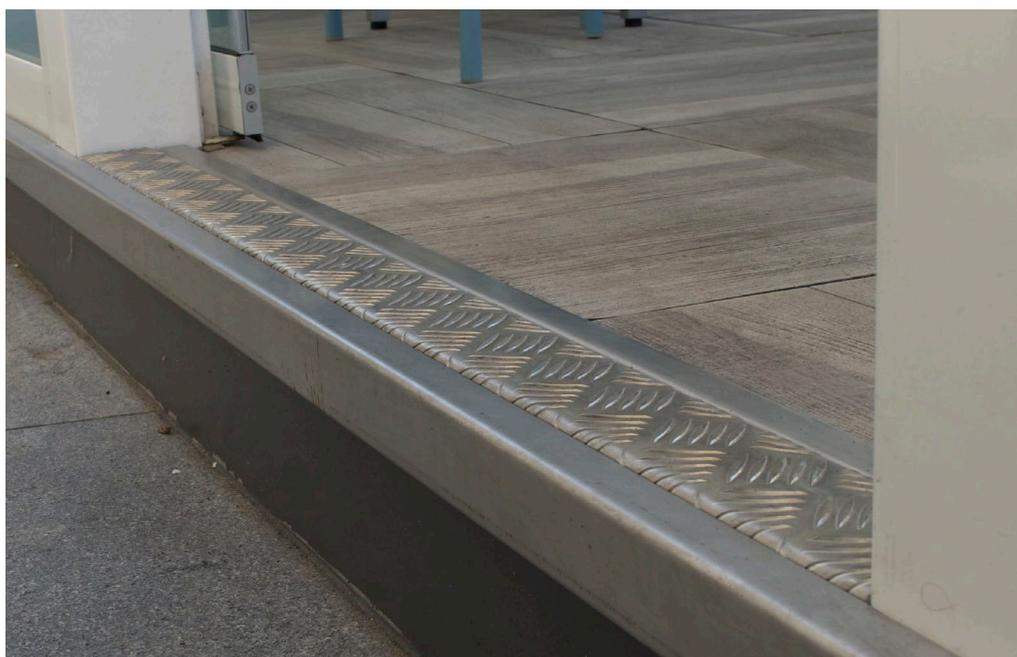
Le colonne di pergole possono essere fissate al perimetro in acciaio della pedana
